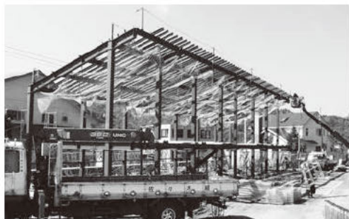
建設中の村営住宅
