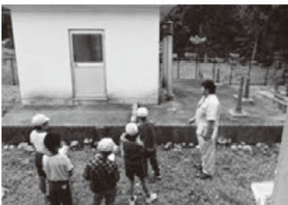
上昭和地区浄水場
