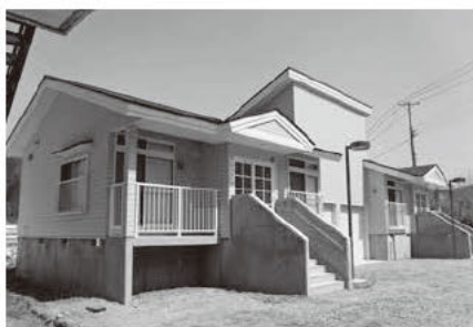
完成した新規就農促進住宅
