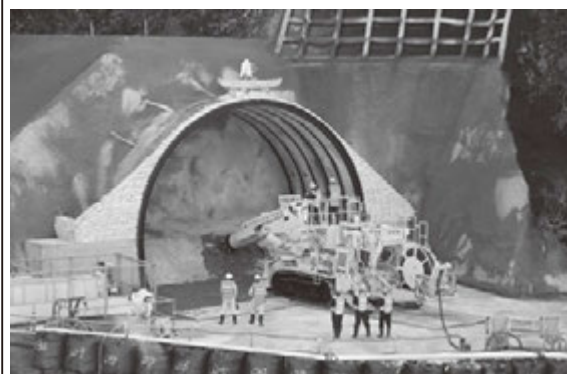
▲トンネルの掘削開始の様子
