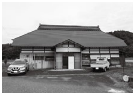
大芦赤田屋。9月17日より解体。
