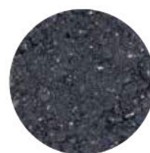
通常の アスファルト 舗装
