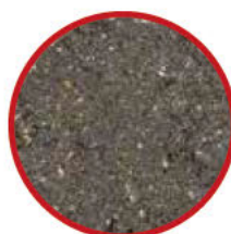
今回採用の アスファルト 舗装1ヶ月後
