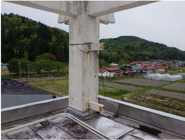
P H階上部西側（外部）
