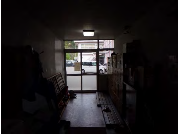
1 階出納室隣廊下 指摘箇所は見られない。
