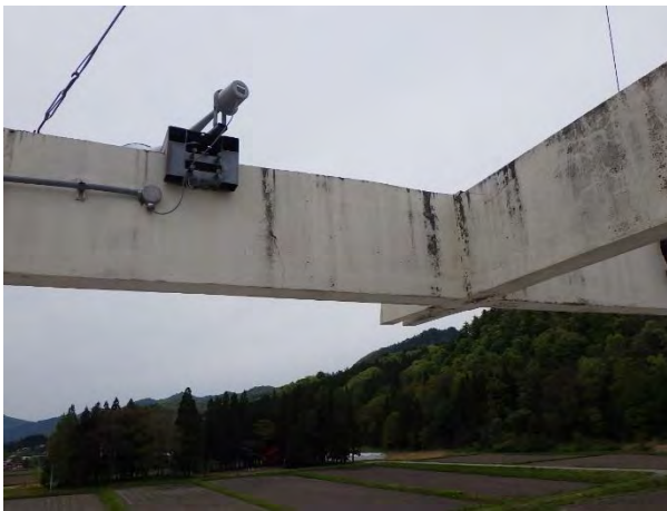
P H階上部北側（外部）
