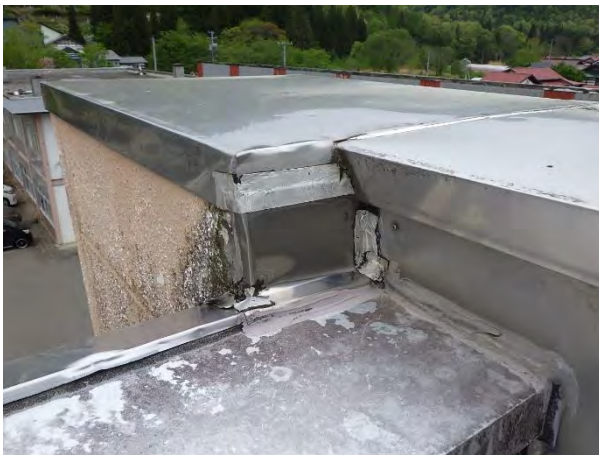
P H階西側（外部） アルミ笠木に変色が見られる。 アルミ笠木の継目に補修跡が見られる
