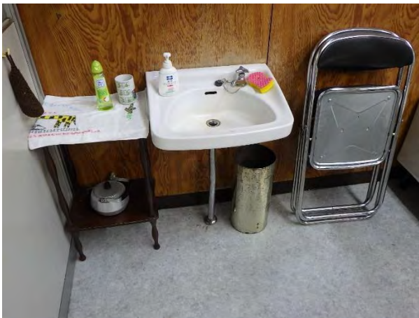
2階議会事務局 壁面の塗装に剥離が見られる。
