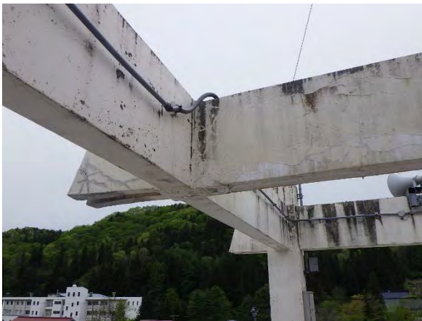
PH階上部南側（外部）
