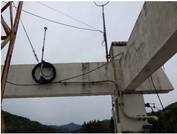
PH階上部東側（外部）
