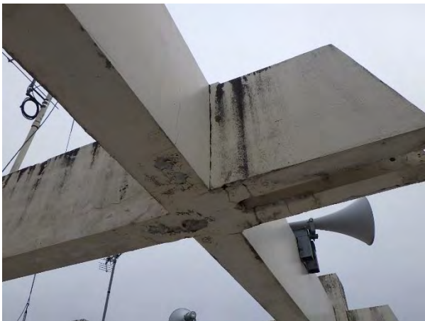
P H階上部北側（外部）
