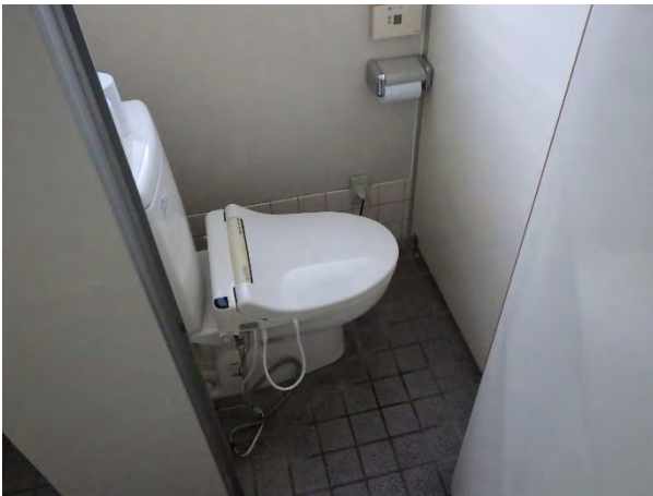
1 階トイレ 指摘箇所は見られない。
