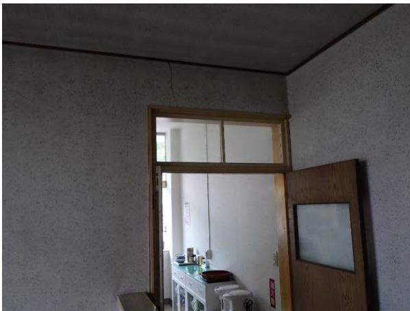
2階湯沸室入口
