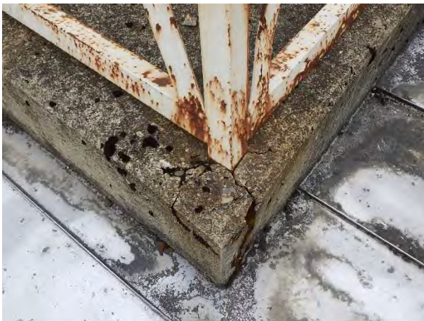
PH階上部中央（外部）
