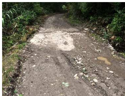
大芦駒止線の路面状況
