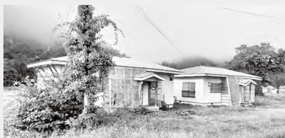
3棟解体 (小中津川字石仏地内)
