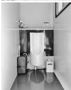
人感センサーを用いた仮設トイレ
