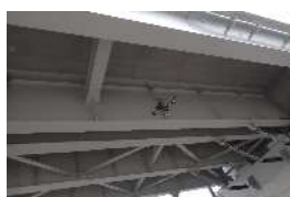
ドローンによる桁下の点検
