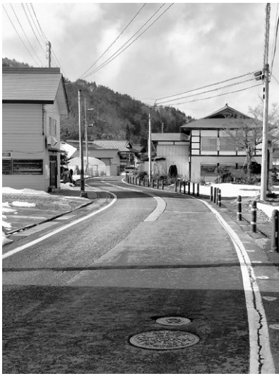
下中津川区長事務所前のカーブ区間は幅員が狭く、車両が鋼製ポールに衝突する事故が多く発生している。
