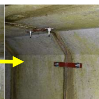
目地部を連結プレートで固定
