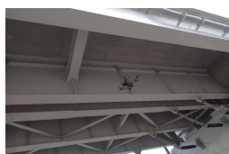
ドローンによる桁下の点検
