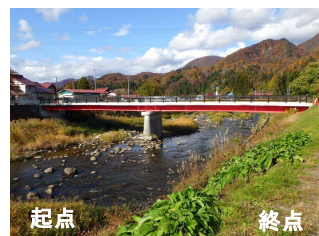
橋梁右側(補修後)
