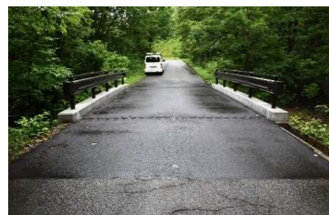
起点側から(補修後)
