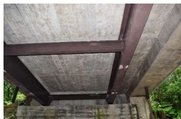
桁下面終点側(補修後)
