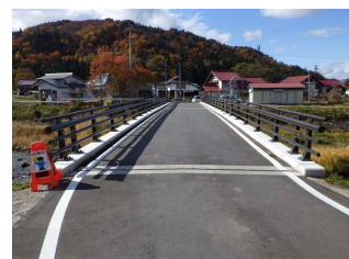
橋面起点側から(補修後)
