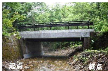
橋梁右側(補修後)
