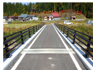
橋面終点側から(補修後)
