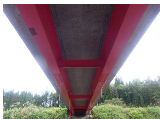
桁下面起点側(補修後)
