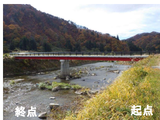
橋梁左側(補修後)
