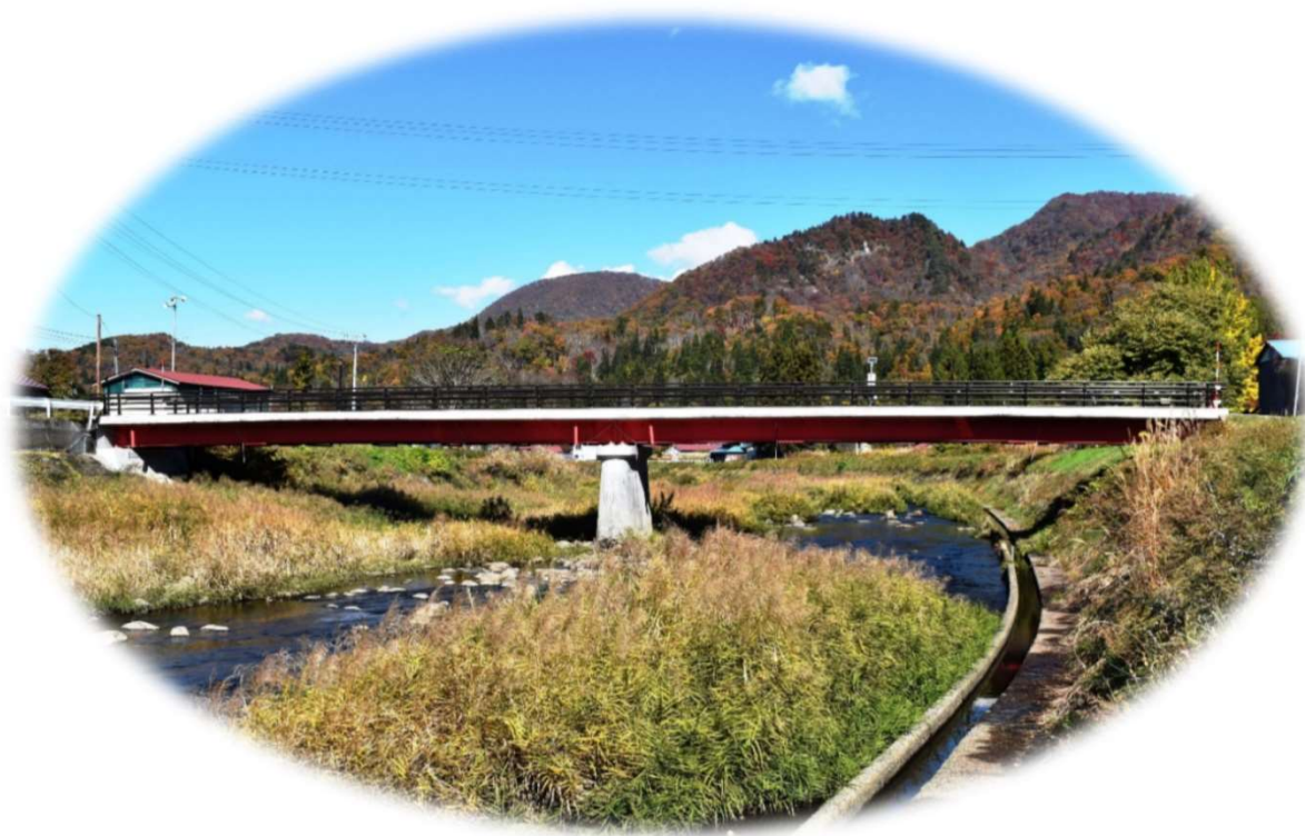
新田橋 (令和4年度補修)
