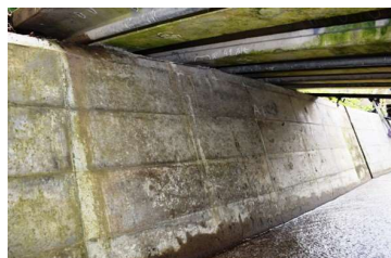
下部工01(水路新設)
