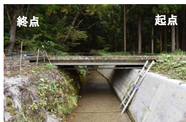
橋梁左側(水路新設)
