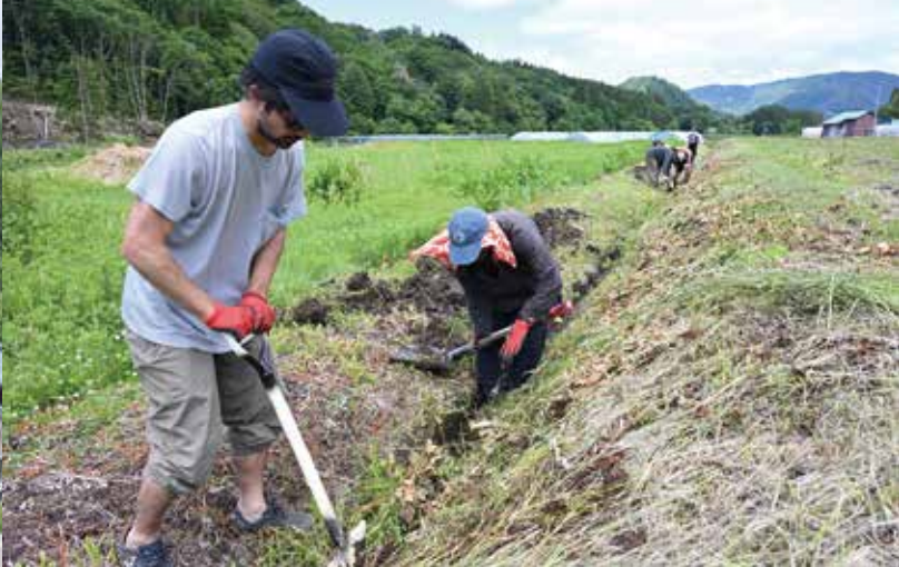
長年使用されていなかった水路の土砂上げ
