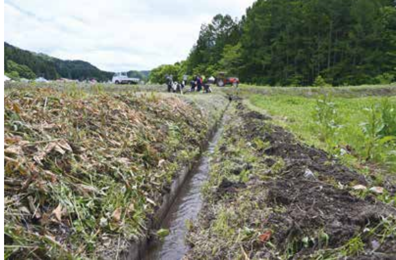
土砂上げにより、復活した水路
